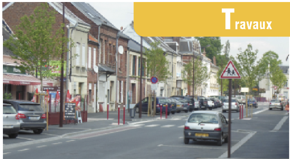
La rue de la République après les travaux
